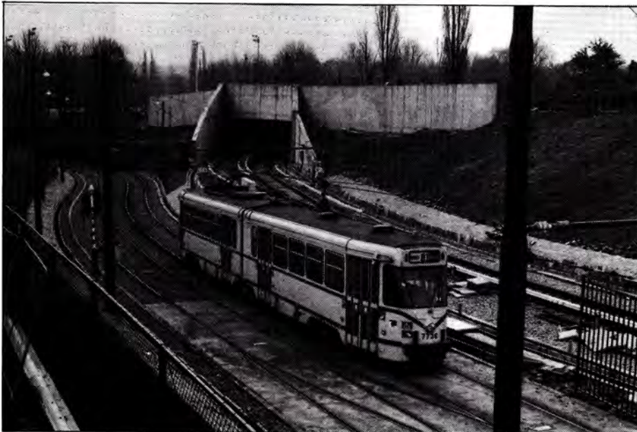
gpcc 7736 op lijn 81 rijdt net weg van het nieuwe tramstation op de Heizel. Op de achtergrond de tunnelingang van metrolijn 1A. Boven de tunnelingang zijn de werken voor de aanleg van het MLP-demonstartietraject aan de gang. Brussel, 26.02.85.
